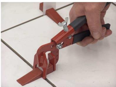
Nach dem Einlegen der benachbarten Fliese drückt man den Keil mit der Spezialzange durch die Lasche bis die Oberfläche beider Fliesen auf gleicher Ebene ist
