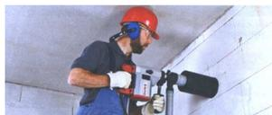
Trockenbohrungen mit Absaugung
